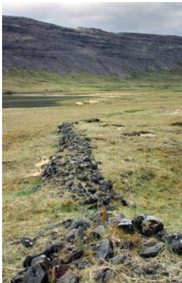
Mynd 6.1. Garðurinn Ranglátur. Grjóttgarður í Sauðlauksdal við Patreksfjörð, sem var hlaðinn árið 1784 til að stöðva ágang sands. Ljósmynd, Sigurður Bogi Sævarsson.
