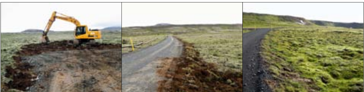
Mynd 12.3. Frágangur á vegkanti. Svarðlagið var tekið ofan af fyrirhuguðu borplani í nágrenninu og lagt strax í vegkantinn. Ári síðar (mynd lengst t.h.) hefur gróðurinn svipað yfirbragð og á aðliggjandi svæði. Ljósmyndir, Gunnar Hjartarson og Herdís Friðriksdóttir.
